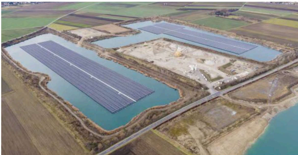
Die erste schwimmende PV-Anlage entsteht derzeit in einem Teich nahe der Marktgemeinde Grafenwörth.
