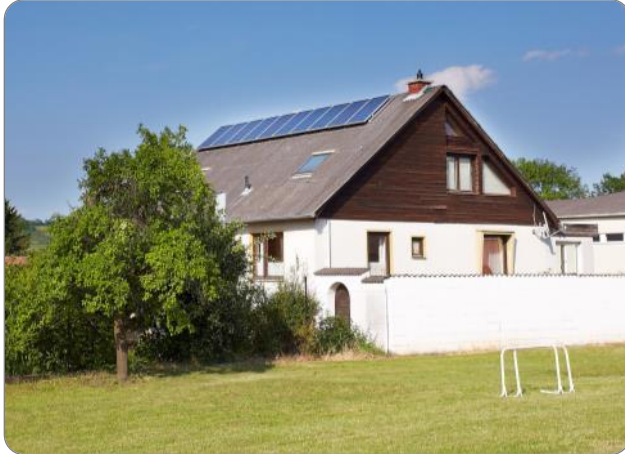
Abbildung 36 Photovoltaikanlagen in der Region 6
