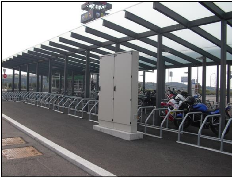
Abbildung 18: Stromkasten im Bereich der Radabstellanlage (Quelle: eigene Erhebung)
