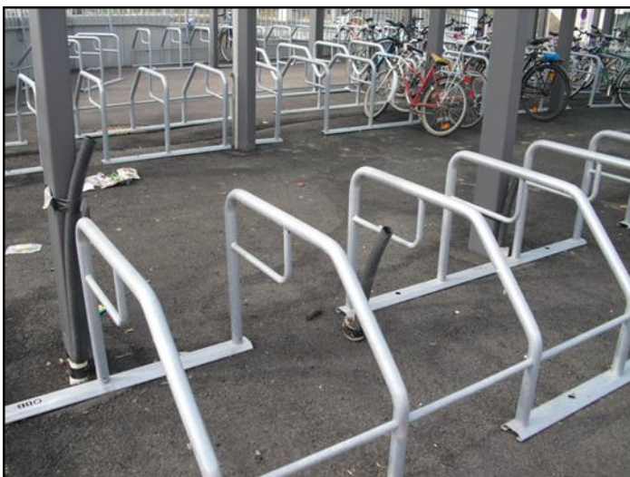
Abbildung 17: Leerverrohrungen sind bei einigen Radabstellplätzen bereits vorhanden (Quelle: eigene Erhebung)
