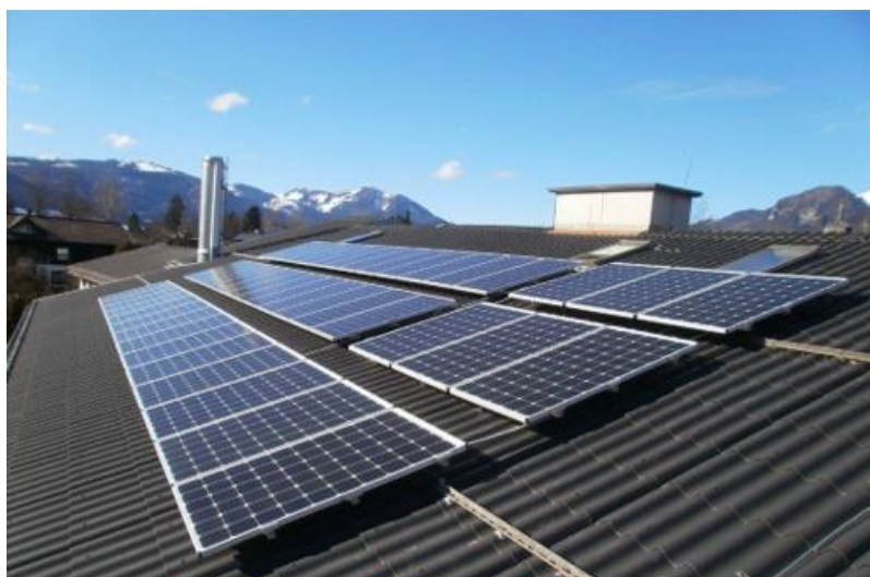
KM-PV auf dem Dach der NMS-PTS Strobl
