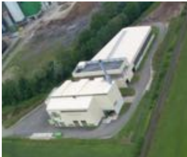
Abbildung 18: BIOMA Energie AG in St. Andrä
