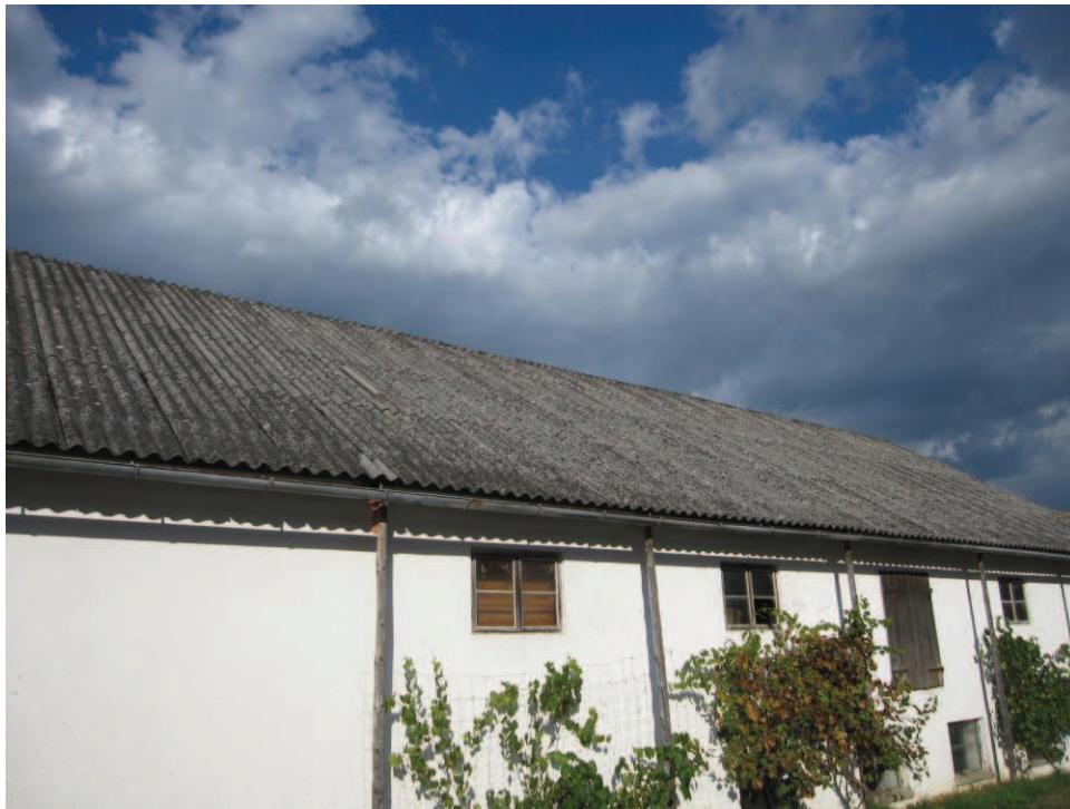
Abbildung 2: Gebäude schwarz Südansicht
