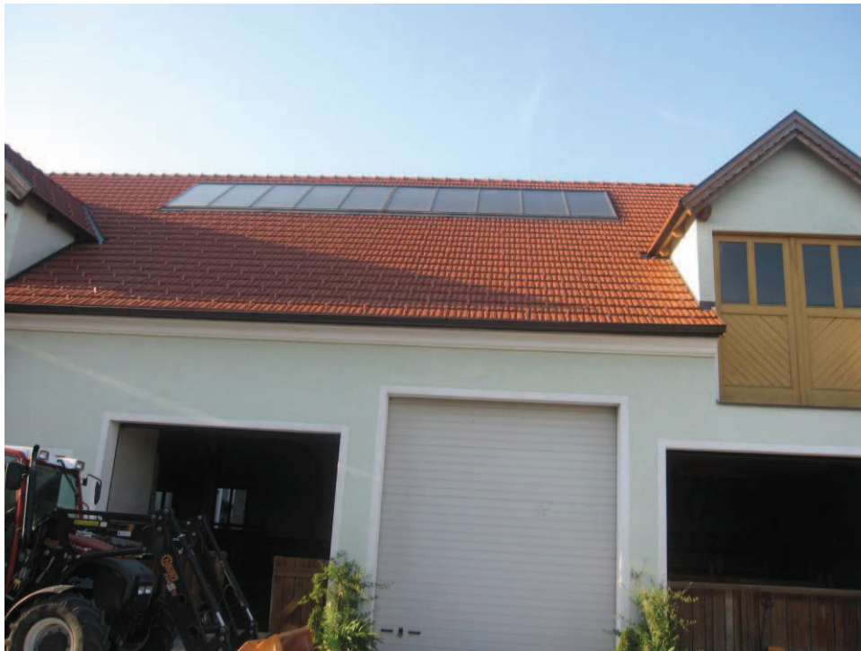
Abbildung 10: Gebäude Nestler Südansicht
