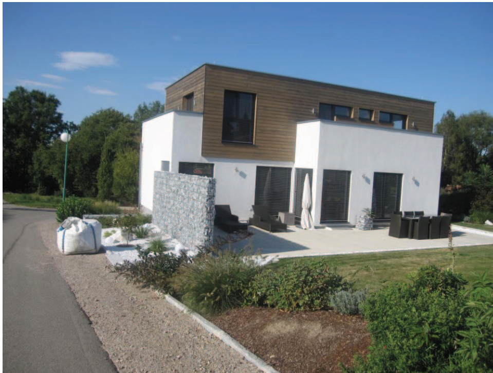
Abbildung 17: Gebäude Gratz Südansicht
