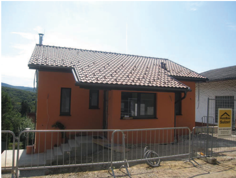
Abbildung 18: Gebäude Thüringer Nordansicht
