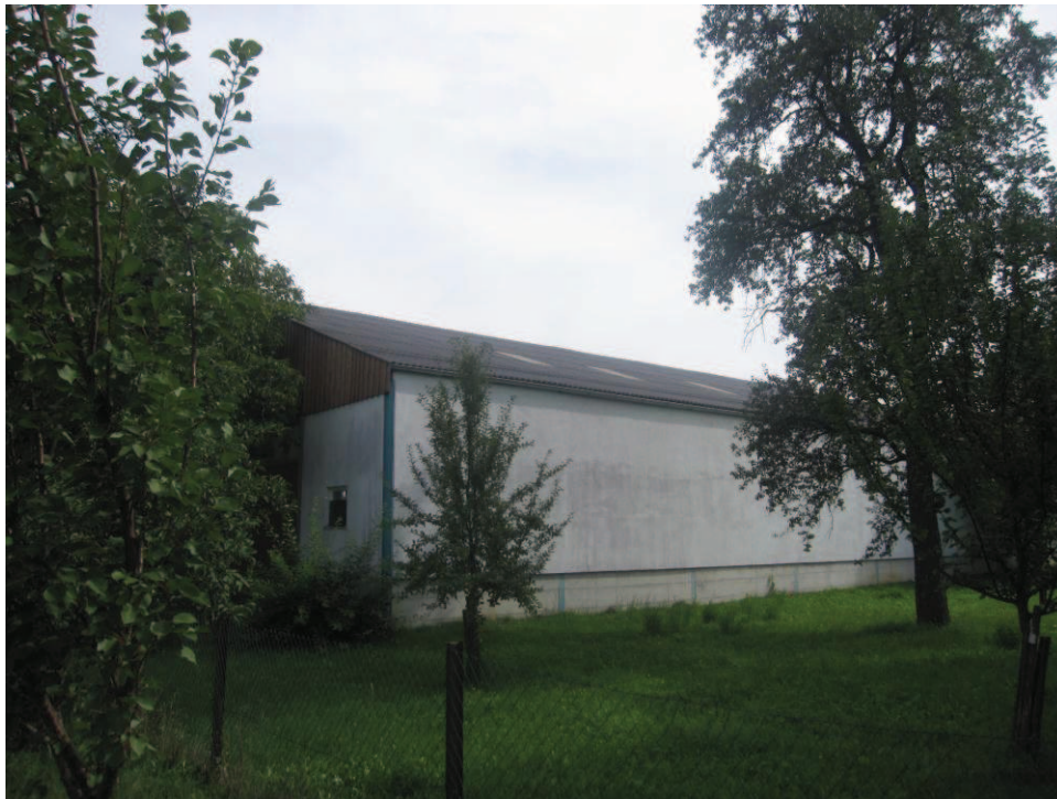
Abbildung 3: Gebäude Fuchs Südansicht
