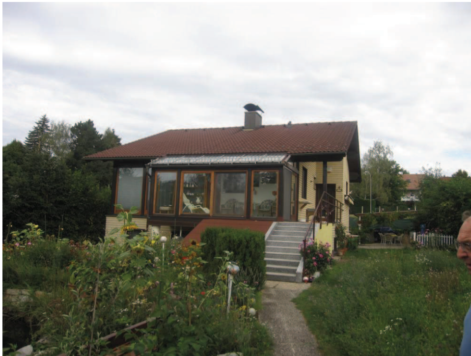
Abbildung 7: Gebäude Kasper Südansicht
