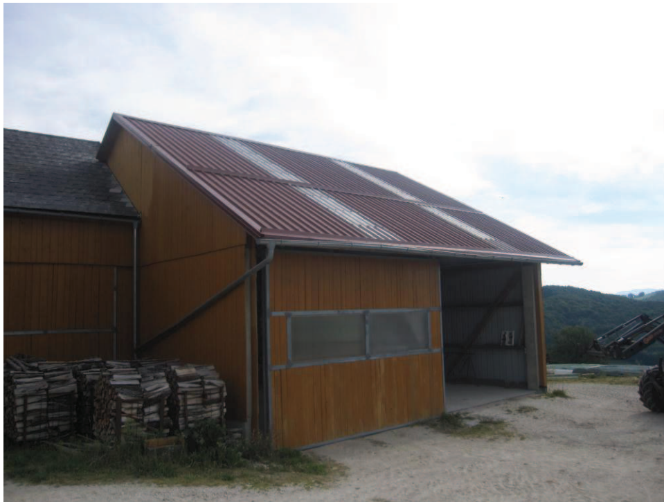
Abbildung 14: Gebäude Büchinger Südansicht
