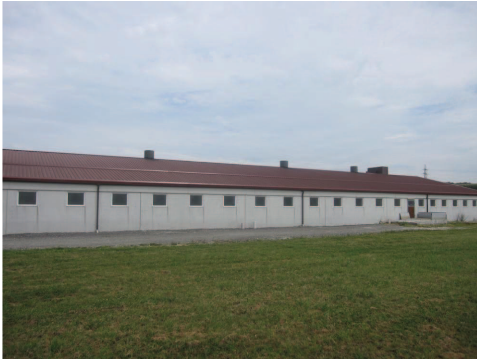
Abbildung 1: Gebäude Deix Südansicht
