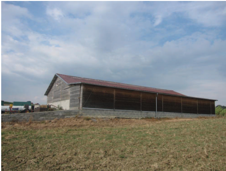
Abbildung 13: Gebäude Gruber Südwestansicht
