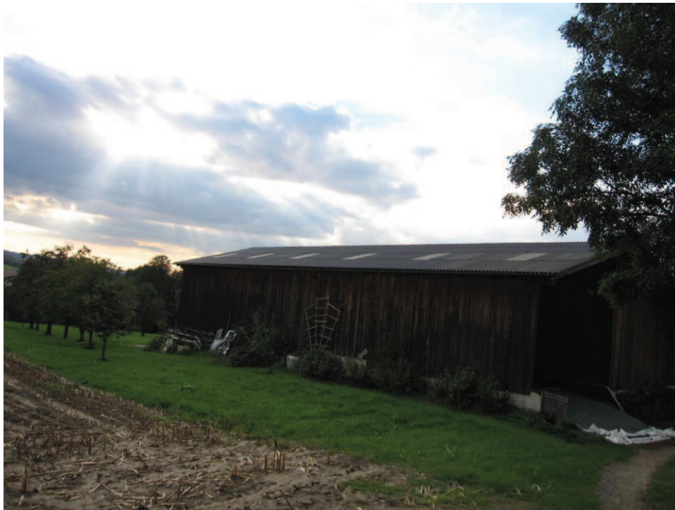
Abbildung 15: Gebäude Moderbacher Südostansicht
