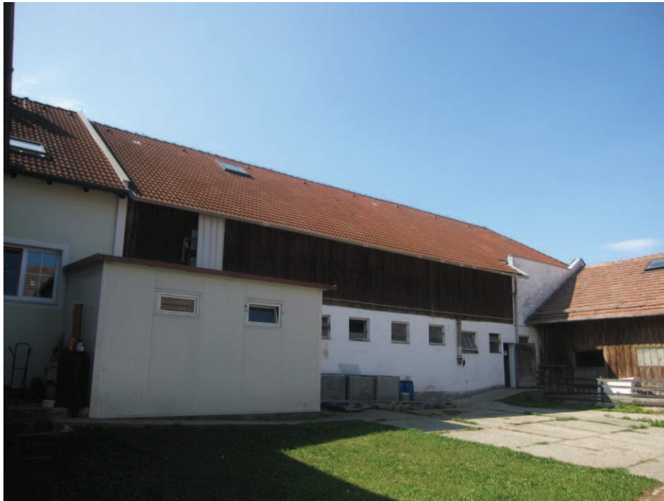
Abbildung 12: Gebäude Lingler Ostansicht
