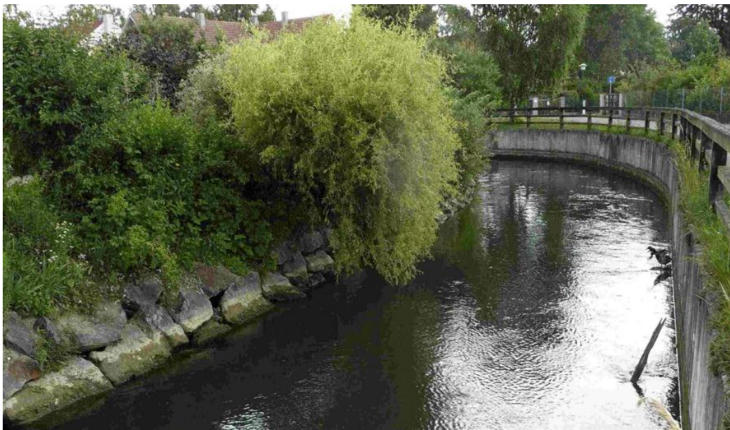
Abbildung 18 Künstlich verbauter linker Mühlbach in Traismauer
