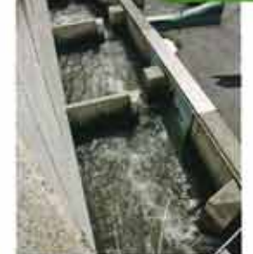
Fischaufstiegshilfe am großen Kraftwerk an der Mur. Um rund Euro 500.000 errichteten Studenten der BoKu dieses Bauwerk. Und es funktioniert: 10.000 Fische (überwiegend Äschen) pro Jahr überwinden diesen seitlich des Kraftwerks angelegten künstlichen Aufstieg.
