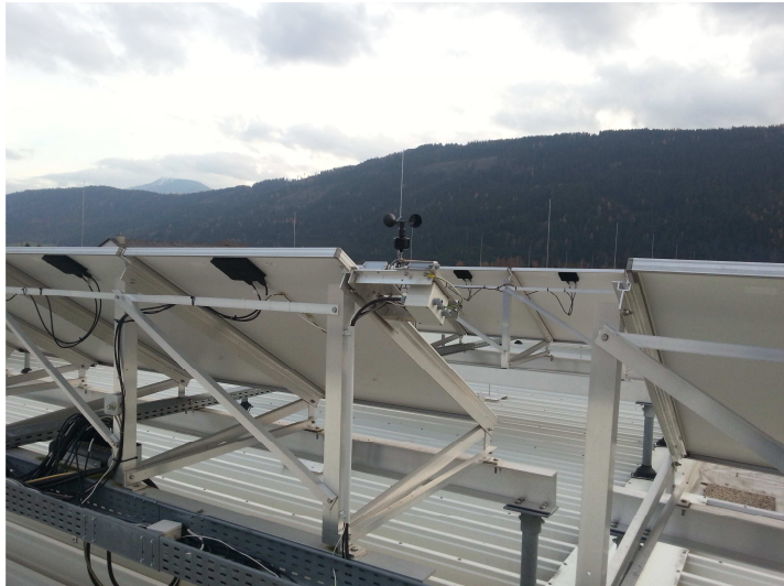
Messtation am Dach des Gewerbeparkes Liezen
