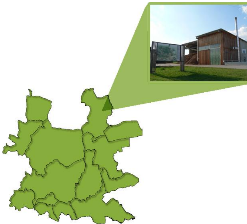
Abbildung 25 Biomasse-Heizwerk in Deutsch Schützen (Bildnachweis: EEE GmbH)
