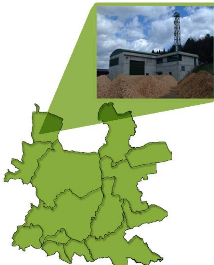
Abbildung 24: Biomasse-Heizwerk in Güttenbach (Bildnachweis: EEE GmbH)
