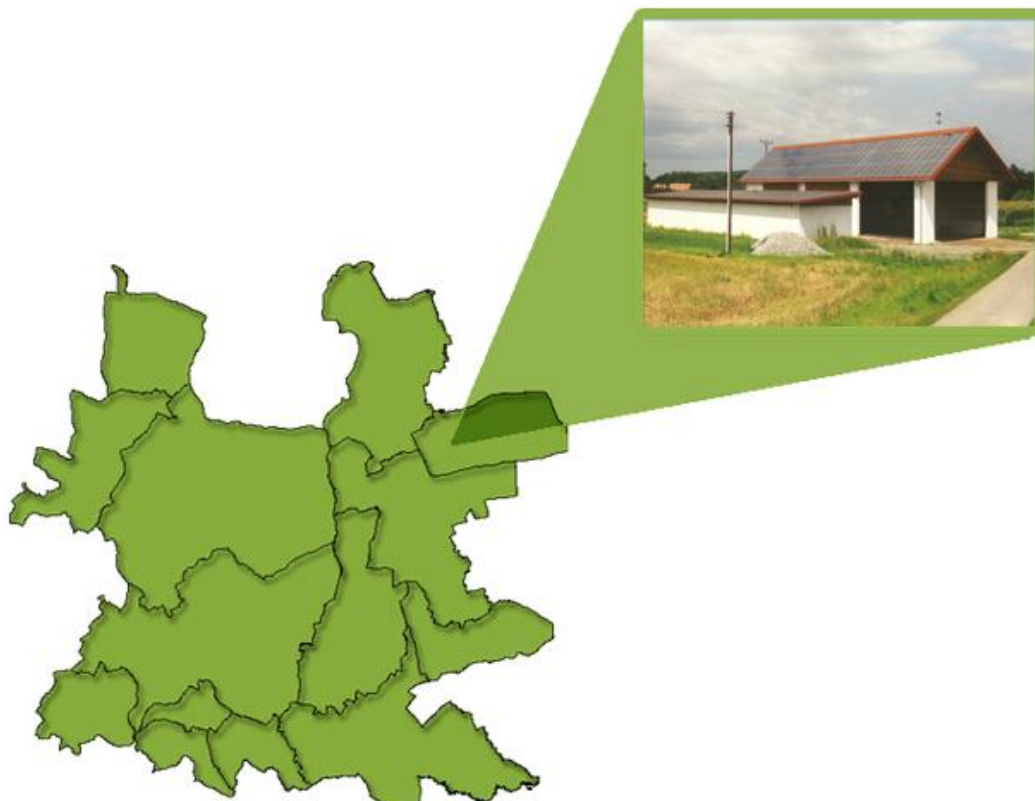
Abbildung 23: Biomasse-Heizwerk in Bildein (Bildnachweis: EEE GmbH)
