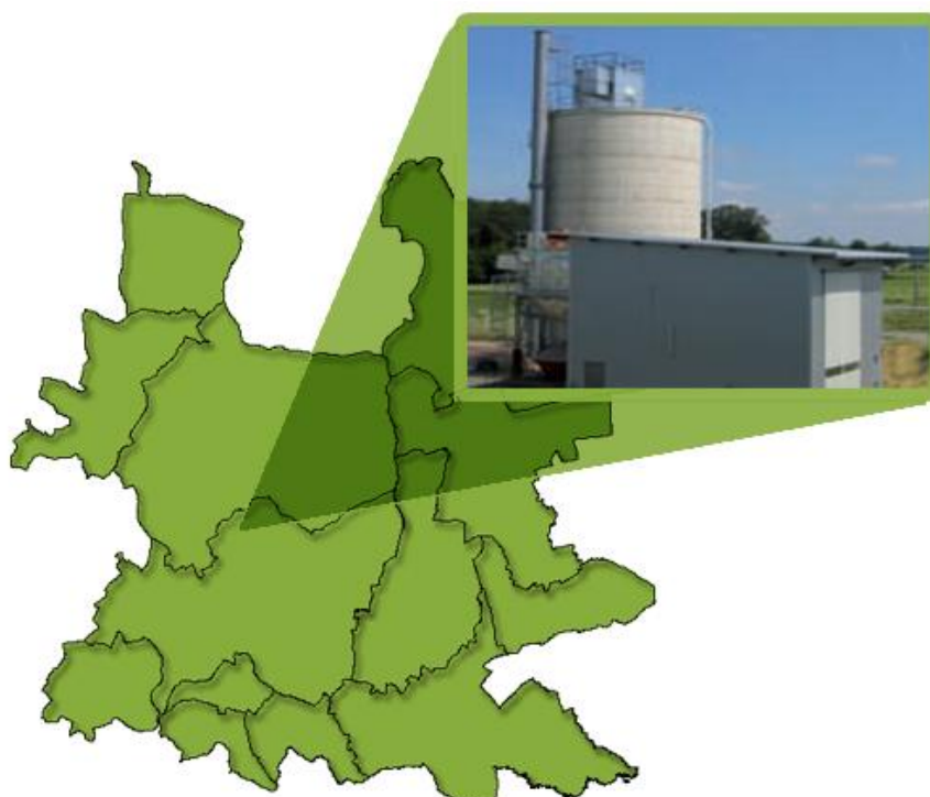
Abbildung 10: Biomasse Fernheizwerk 2 in Güssing (Bildnachweis: EEE GmbH)
