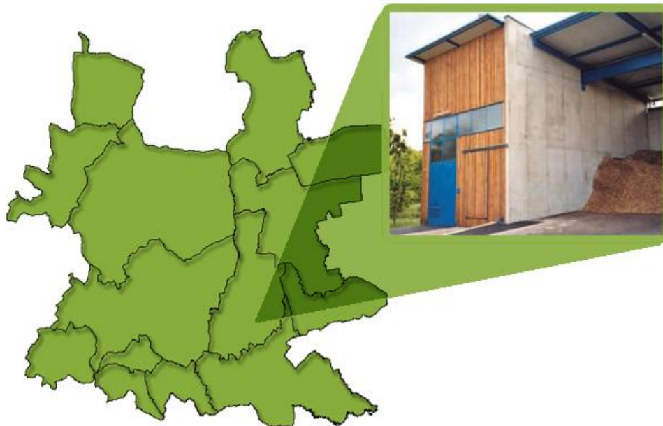
Abbildung 16: Biomasse-Heizwerk in Strem (Bildnachweis EEE GmbH)
