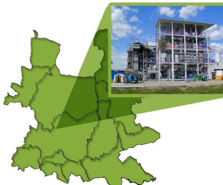
Abbildung 13: Methanierungsanlage (Forschungsanlage zur Erzeugung von BioSNG) in Güssing (Bildnachweis: EEE GmbH)
