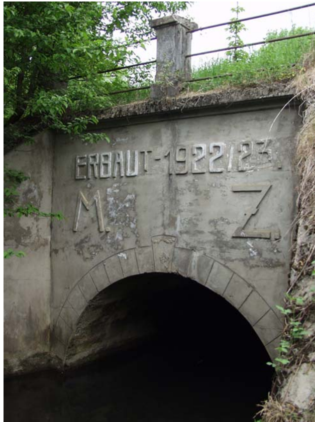
Abbildung 4-9: Das Auslaufgerinne eines Kraftwerks an der Tiebel [Senitz, 2007]
