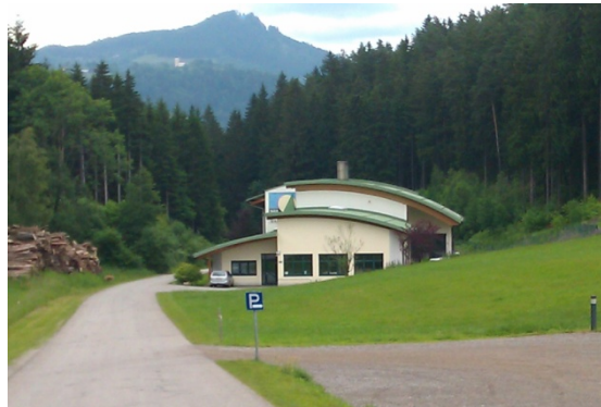
Abbildung 4-12: Biomassekraftwerk der Nahwärme Waiern
