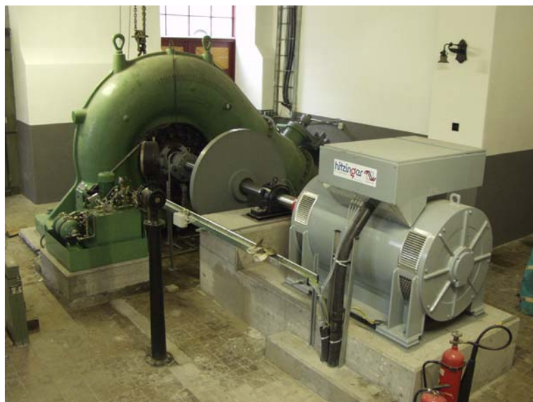
Abbildung 7-4: Turbine und moderner Synchrongenerator nach erfolgter Sanierung (Senitzka, 2007)
