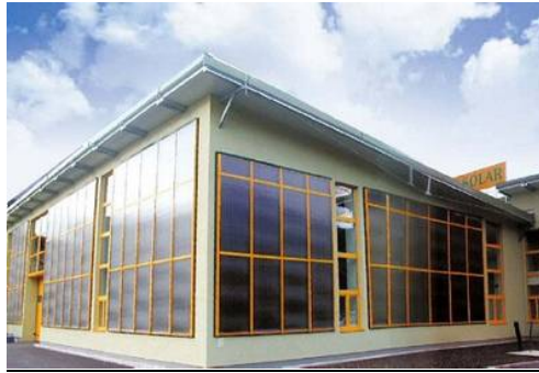
Abbildung 7-9: 138 m 2 (97 kWth) Sonnenkollektoren in der Südfassade beheizen die Produktionshalle der Firma Siko Solar in Jenbach/Tirol (Foto: Siko Solar)
