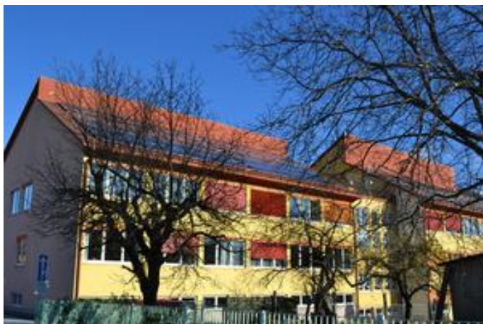
Bürgerbeteiligungsanlage am Dach der NMS Köflach (Quelle: Stadtwerke Köflach GmbH Juni 2014).
