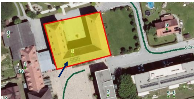
Die Abbildung zeigt die Volksschule Bärnbach mit der im Rahmen der Investitionsförderung des Klima- und Energiefonds installierten PV-Anlage (Quelle: GIS Steiermark Juni 2014).
