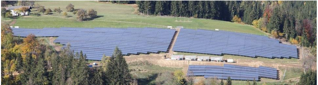
Gesamtansicht Öko Park Lorder (Quelle: Stadtwerke Köflach GmbH Juni 2014).
