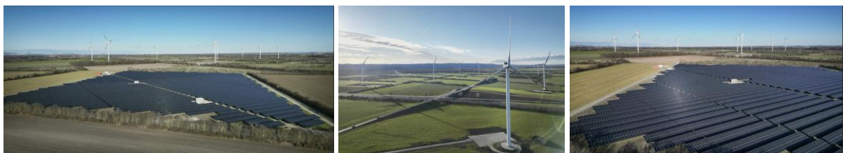
Windpark und Photovoltaikanlage in Trumau, Quelle/Fotos: Wien Energie GmbH
